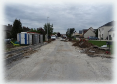
Travaux rue de Caslin
